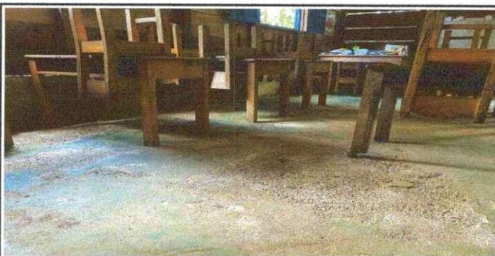
Foto 5: Piso quebrado con áreas que no han sido alisadas adecuadamente del salón de clases y patio.
