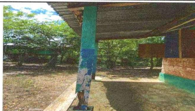
Foto 2: Los horcones que soportan la estructura muestran un debilitamiento severo debido a la constante exposición a la lluvia y plagas.
