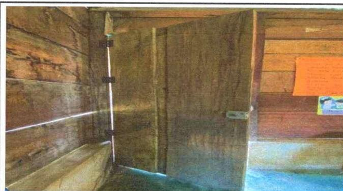
Foto 4: la puerta principal tiene dificultades para cerrar correctamente, asimismo el deterioro de dicho material.
